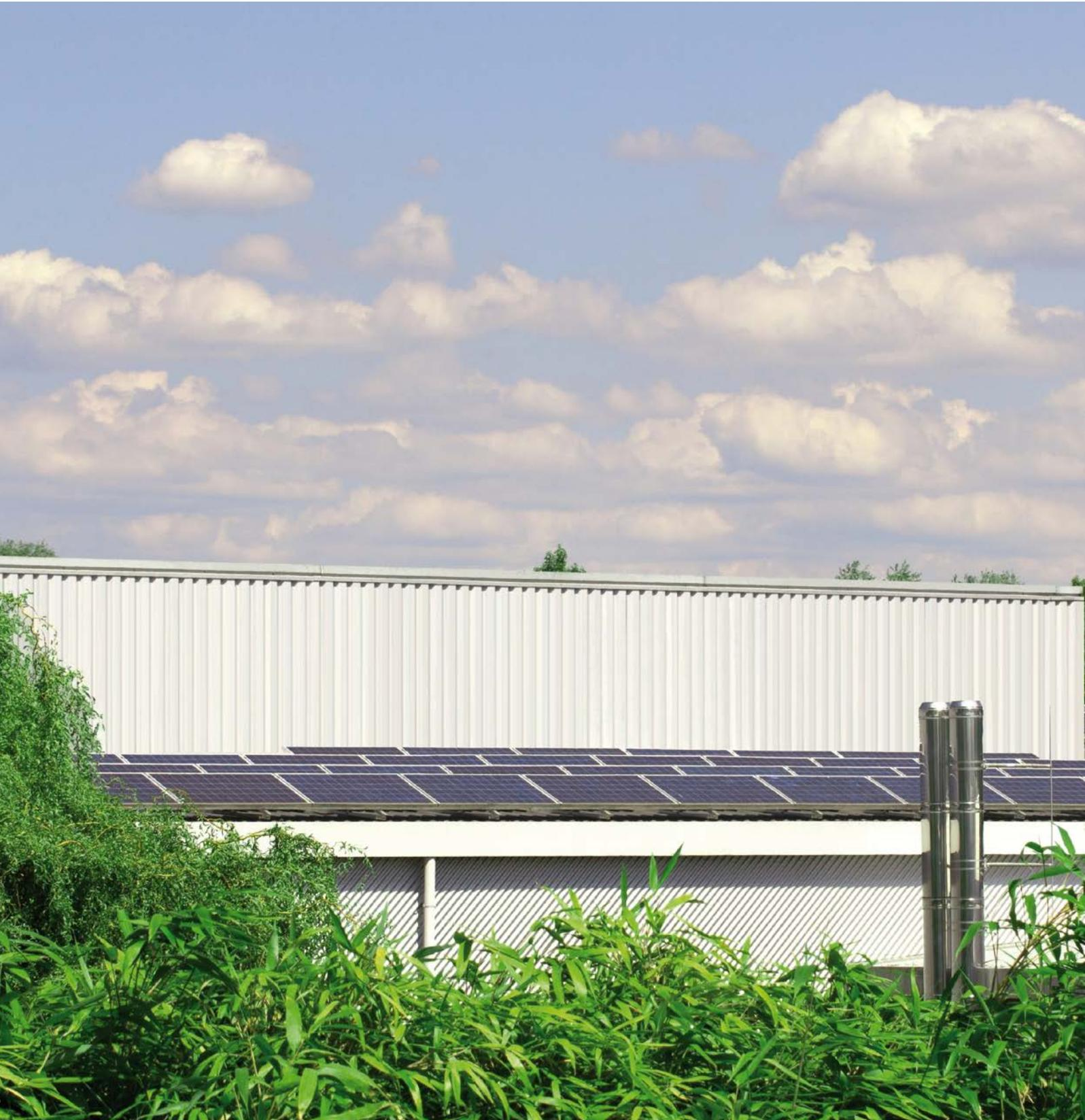
» Die Photovoltaikanlage auf den Dächern unserer Produktion **mit einer Modulfläche** von über **1.940 m<sup>2</sup>** und einer **Nennleistung von 273,36 kWp** erzeugt bereits seit mehr als drei Jahren solaren Strom.
